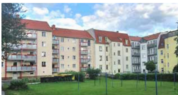
Freiberg, Breithauptstraße 4/12/5/9/17 (ICD 10 R+)
